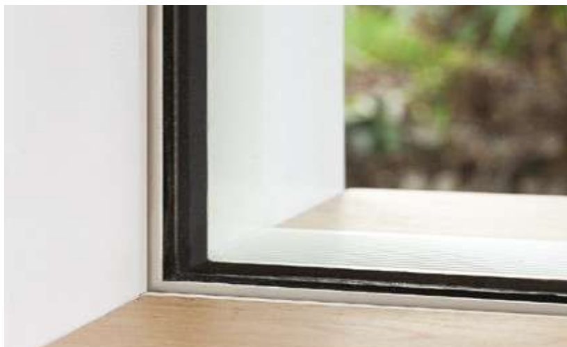
Soluzione ONE: profilo totalmente incassato visibile per soli 4 mm.
