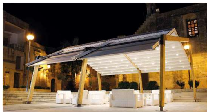
Struttura in legno con copertura in PVC
